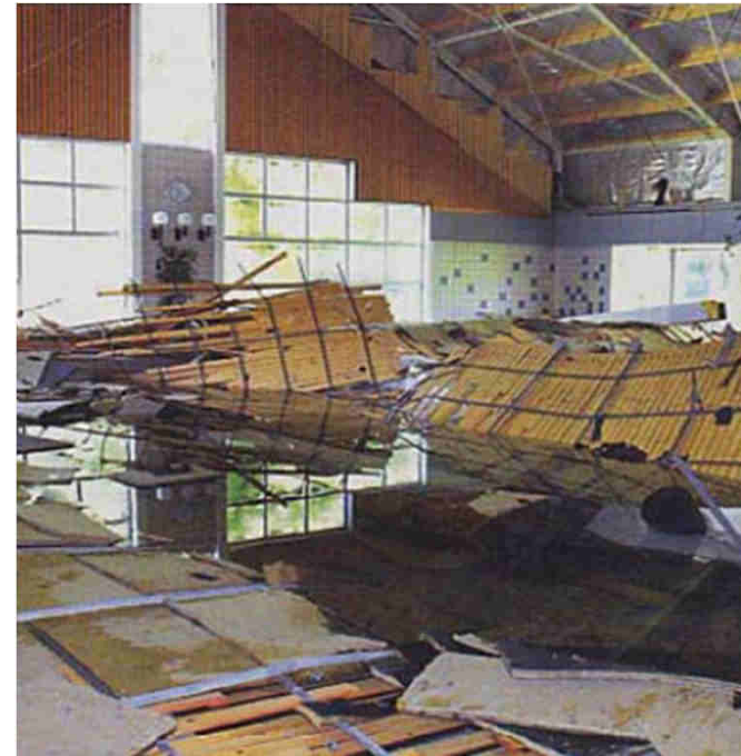
Plafond instorting in Steenwijk Nederland
